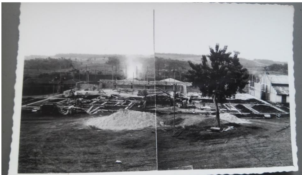
Figura 1: Foto da Construção do Centro Social
