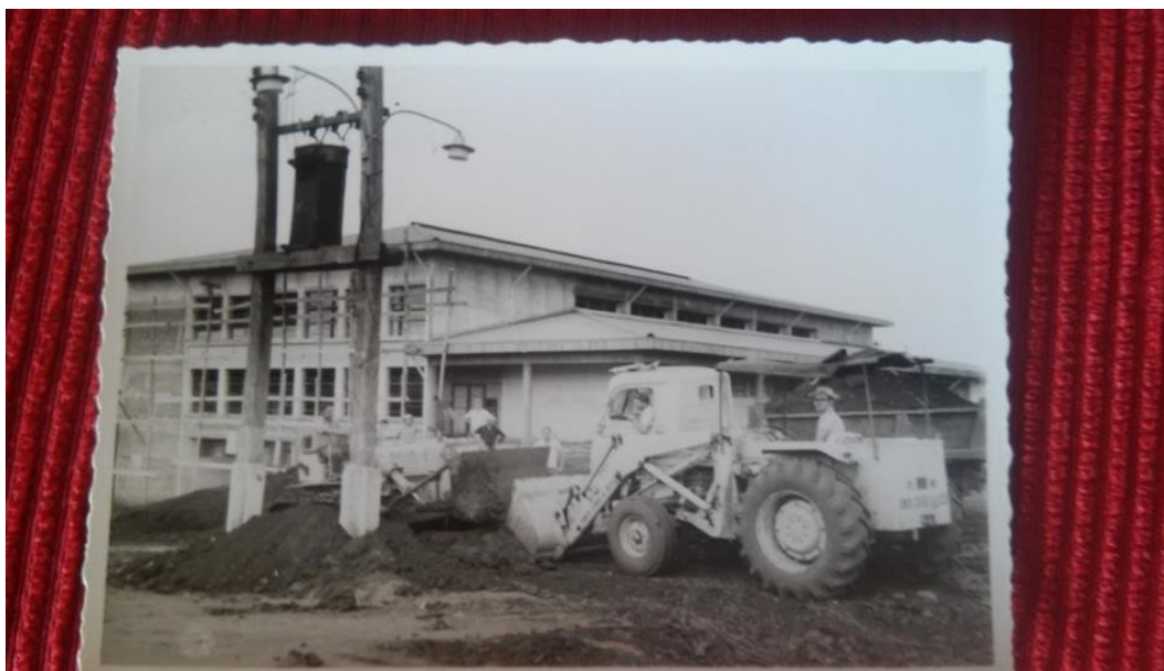
Figura 2: Foto da Construção do Centro Social
