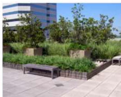
figura 5 - Exemplo de telhado verde de uso intensivo - Houston, USA Fonte: GREEN ROOF TECHNOLOGY (2012)
