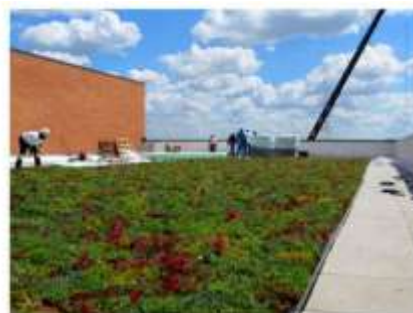
figura 7- Exemplo de cobertura de uso Extensivo - Chicago – USA Fonte: GREEN ROOF TECHNOLOGY (2012)
